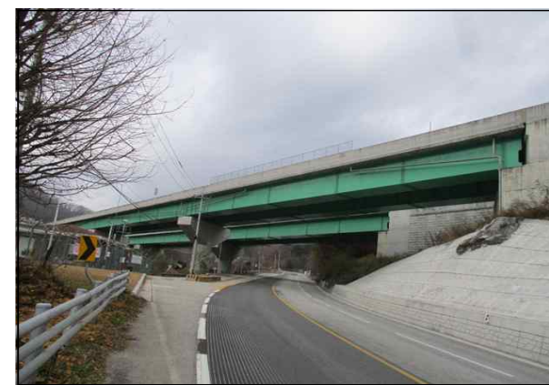
조양교(양양) 측면 전경
