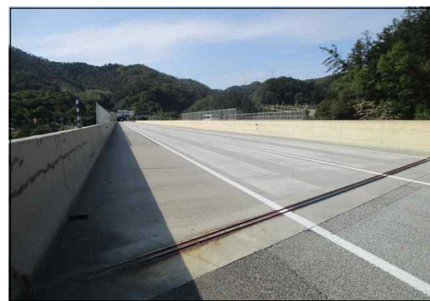
조양교(양양) 상부 전경
